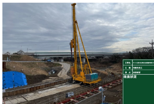
写真-1 機械攪拌工施工状況
