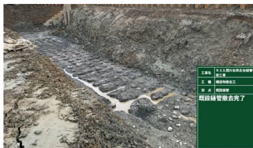
写真-2 既設樋管撤去完了
