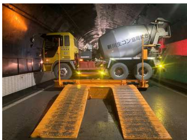
写真 3-1 ターンテーブル設置
