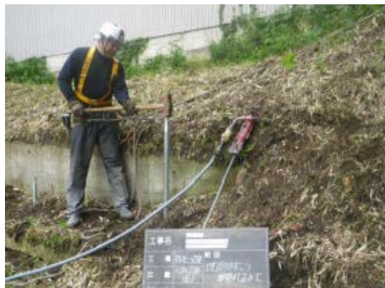
写真-3 既設排水溝縦壁補強アンカー打込み
