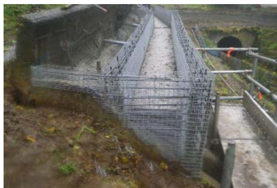
写真-4 排水溝部組立状況
