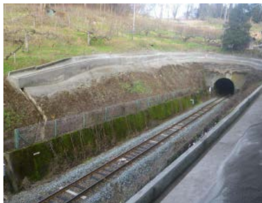
写真-5 吹付排水溝全景
