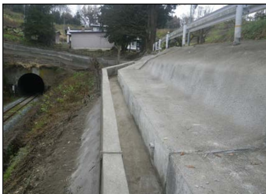
写真-6 吹付排水部詳細
