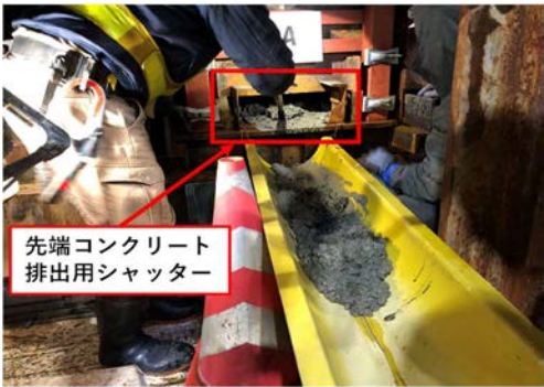
写真-1 先端コンクリート排出状況
