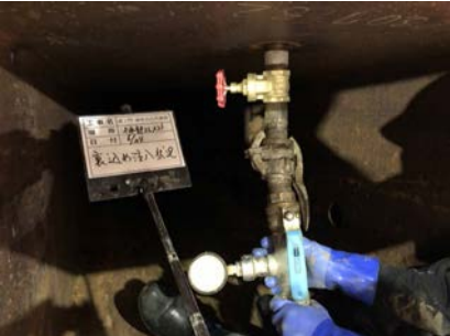
写真-1 裏込め注入状況
