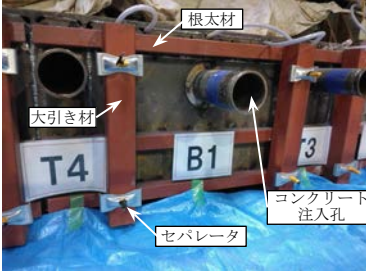
写真-3 コンクリート止め枠
