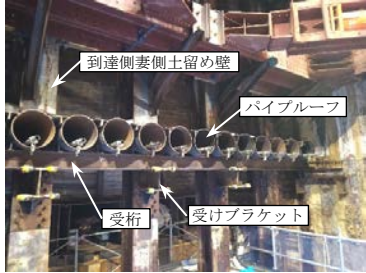
写真-2 パイプルーフ設置状況
