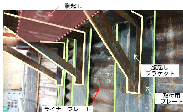
写真2 立坑ブラケット設置状況 断面図
