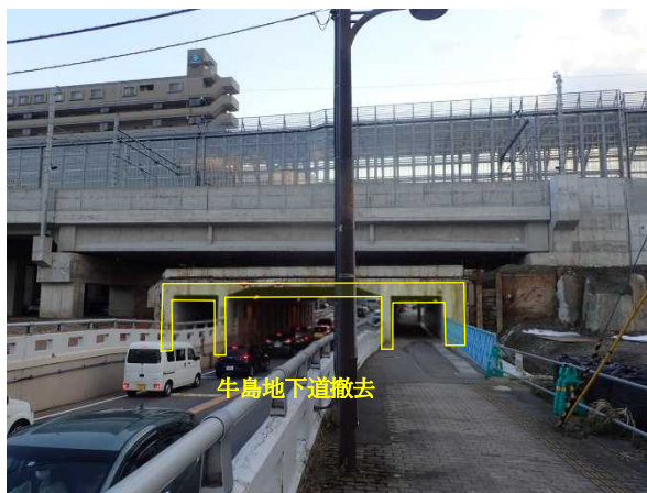
写真-1 着手前全景
