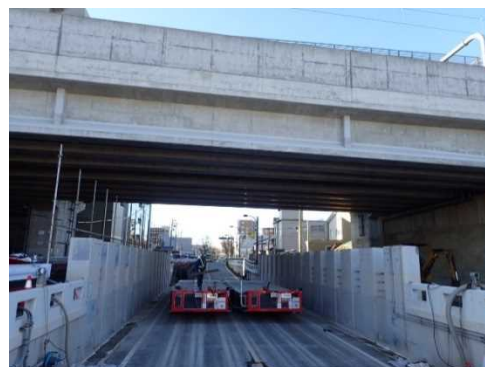
写真-6 車道頂版撤去完了全景
