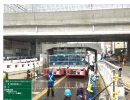
写真-3 ブロック搬出状況
