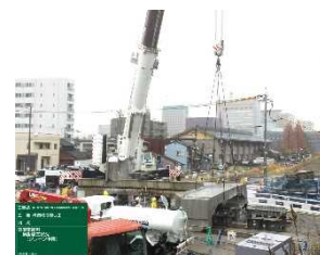
写真-4 ブロック楊重状況
