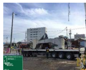
写真-5 ブロック積込状況
