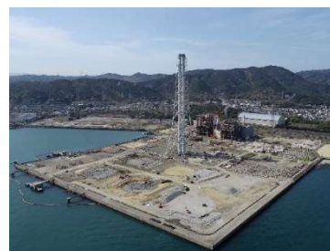
写真-1 工事箇所全景
