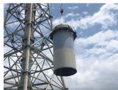
図-5 煙突筒身切断部材の吊下げ状況概念図と作業状況
