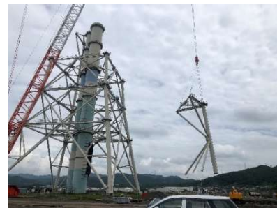
図-4 鉄塔切断部材の吊下げ状況概念図と作業状況
