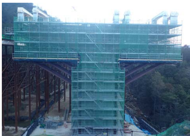
写真-1 大型ブラケット設置状況
