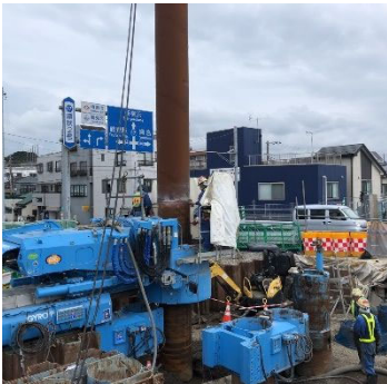
図 5. 1 鋼管杭打設状況
