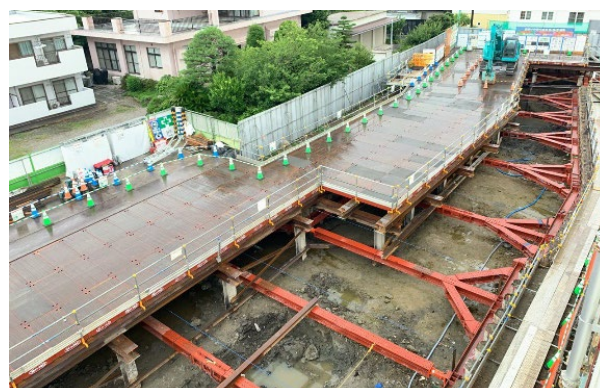
写真-3 覆工板全景
