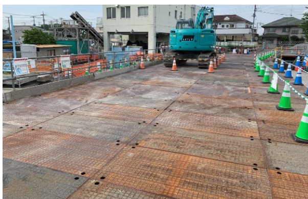
写真-2 覆工板状況
