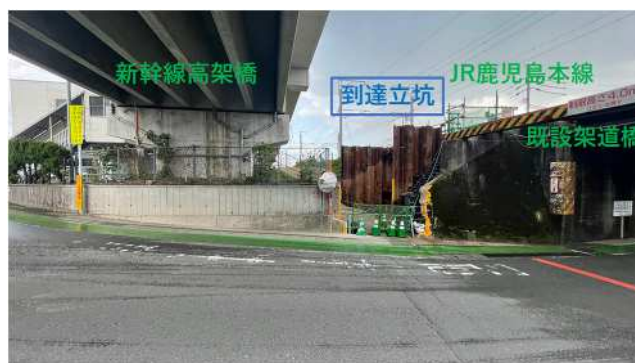
図-5 到達側施工ヤード
