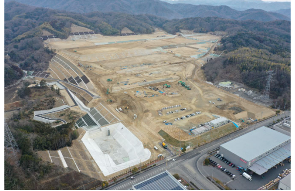
写真-1 現場全景状況(出来高85%時点)
