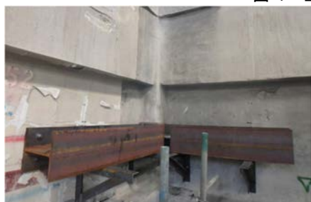
写真-1 隅角部鋼材設置状況
