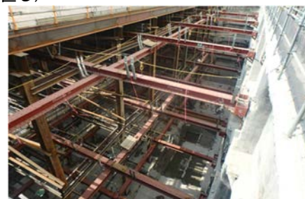
写真-3 架設完了状況
