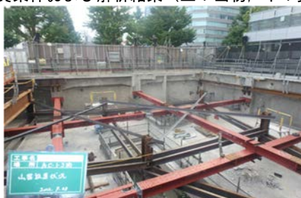
写真-2 土留支保工設置状況
