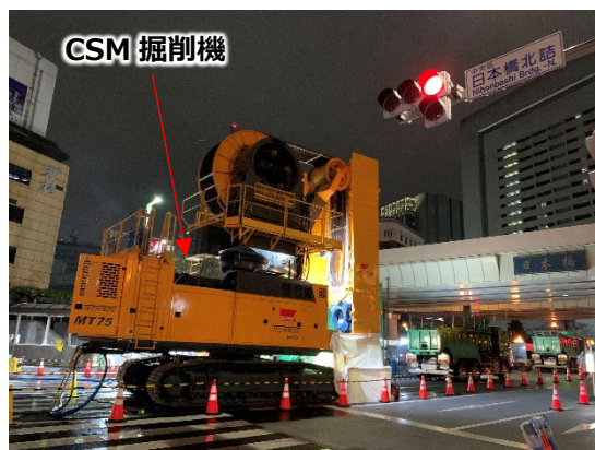
写真－1 CSM 地中連続壁工掘削施工状況
