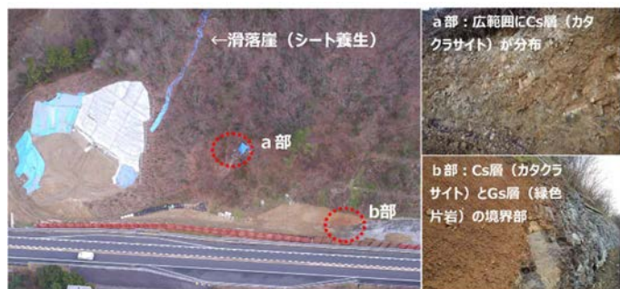
図-1. 被災現場状況とカタクラサイト
