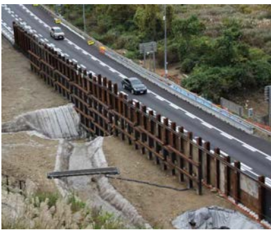
写真-3 応急復旧完了時の状況
