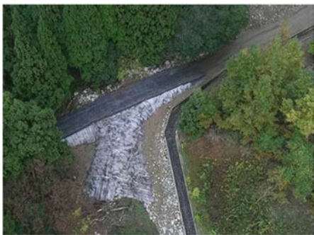
写真-2 仮設導流工
