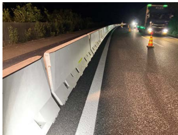
写真 1 SSS ガード設置状況
