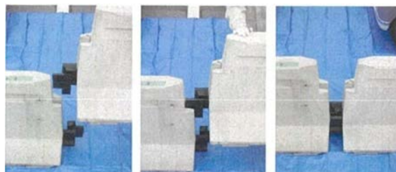
図 2 SSS ガード設置連結状況
