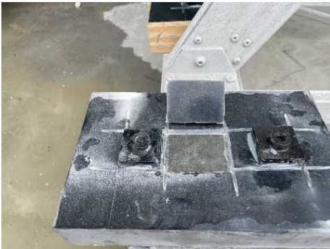
写真-1 ①試験体の破壊状況
