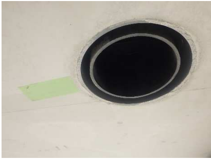
写真-4 漏水対策桝の下面
