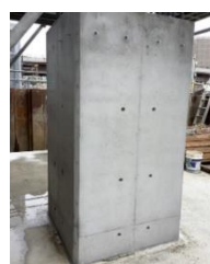
図-8 柱側面の状態
