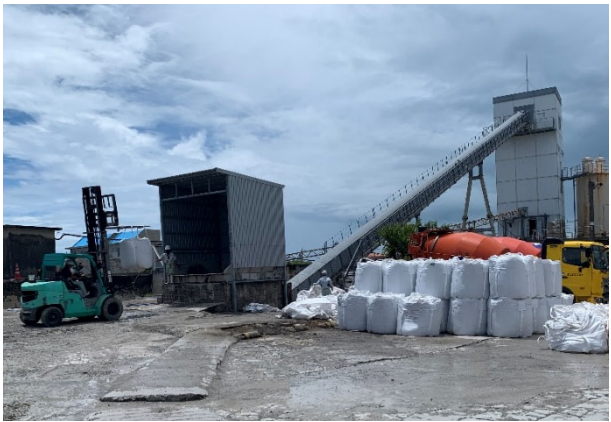
写真-1 軽量骨材貯蔵状況
