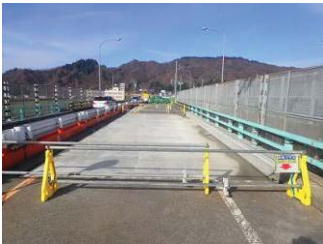
写真-3 合成床版コンクリート 打設後(上り線)
