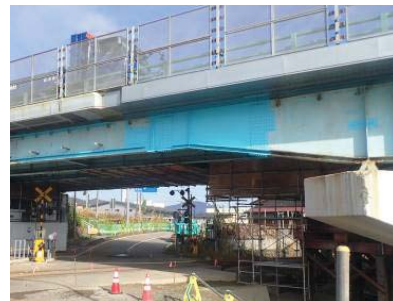
写真-2 G1-G2 桁ゲルバー部 連続化 施工後(下り線)
