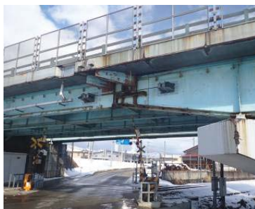
写真-1 G1-G2 桁ゲルバー部 連続化 施工前(下り線)
