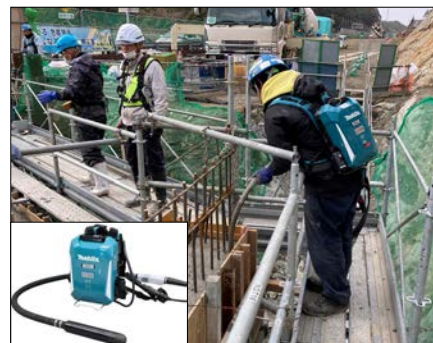
写真 3 バイブレータ使用状況
