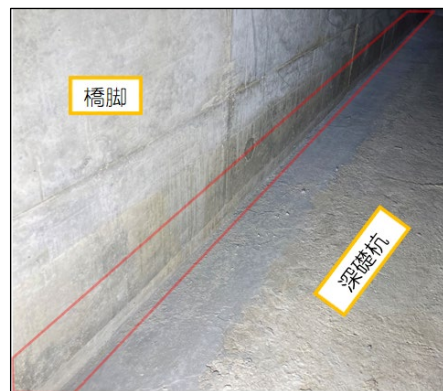
写真 2 打設完了(橋脚基部)
