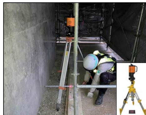
写真 6 レーザー鉛直器使用状況
