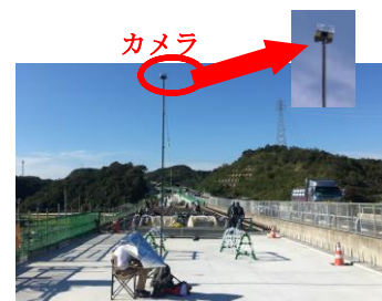
写真-1 機材の配置状況
