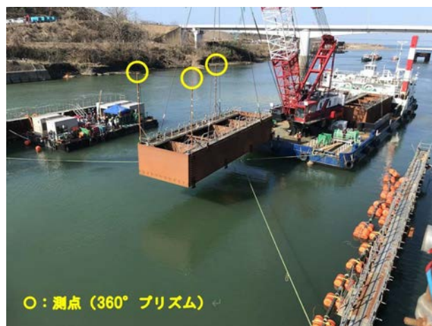
写真-3 減勢工鋼殻据付状況
