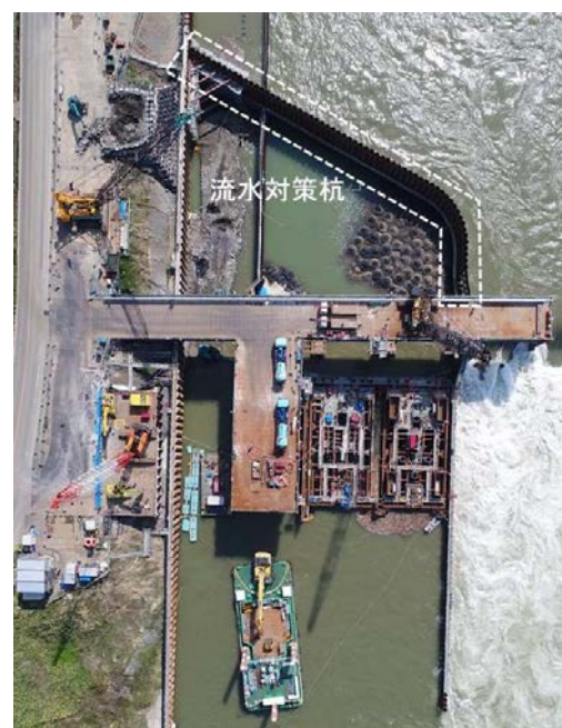
写真-2 流水対策杭内での船舶作業
