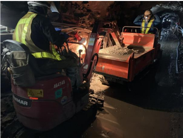
写真-1 施工状況(コンクリート練返し状況)
