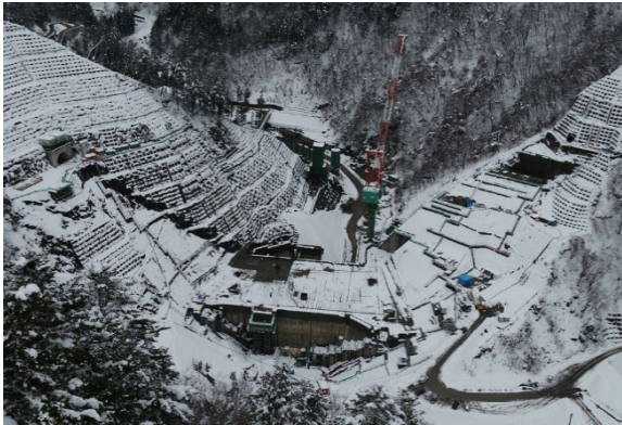
写真1 内ヶ谷ダム堤体上流側全景
