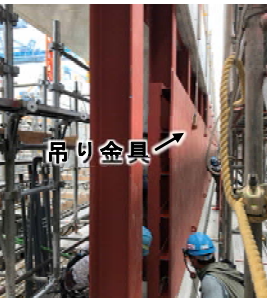
写真-2 パネル材設置状況
