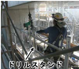
写真-1 アンカー孔上向き削孔
