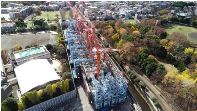
写真-1 施工状況全景
