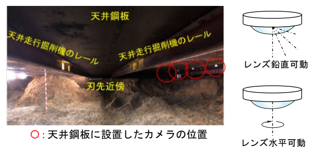
図3 函内のカメラ設置状況写真
