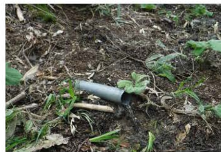
写真-1 PDR 打設完了写真
