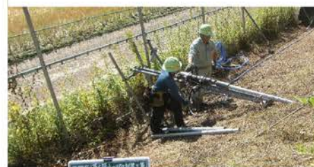
写真-2 PDR 施工状況写真
