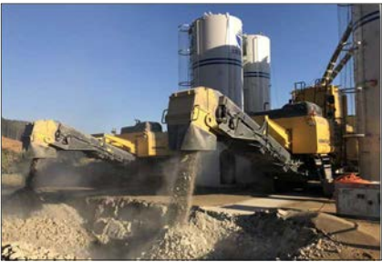
写真1 改良土製造状況
