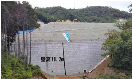
写真2 施工完了状況
