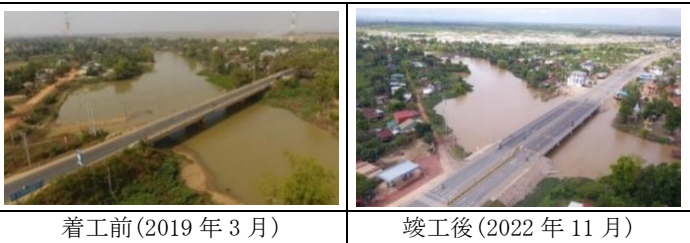
写真-1：橋梁部 (No. 59 橋) の状況
