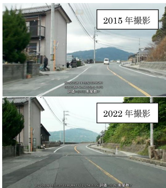
図-3 3300m付近；下水道工事仮復旧舗装状況
