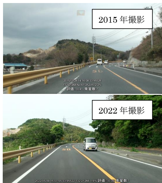
図-4 3550m 付近；舗装補修工事状況
