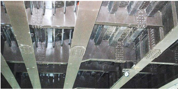
写真-1 軌道と道路で主桁や床版の構造が異なる例 (幸橋, 福井県福井市)
