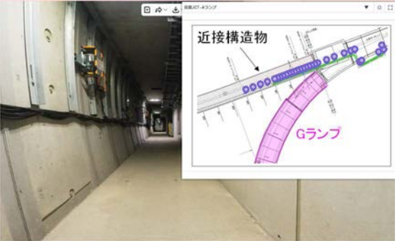
図-5 近接構造物の施工前状況の記録
