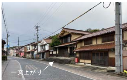
図3 一文上がりの建物 (水害防止目的で土地を高くした建物)
