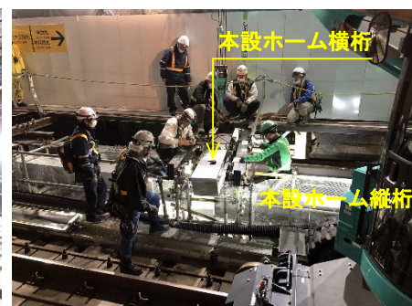
写真-8 本設ホーム横桁設置状況
