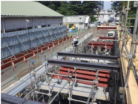
写真-1 試験施工の状況
