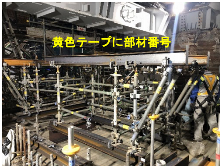
写真-2 仮ホーム支保工仮組状況
