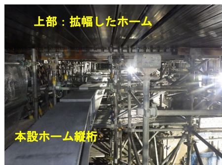
写真-7 本設ホーム縦桁設置状況
