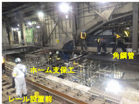
写真-4 仮ホーム支保工組立状況(前半)
