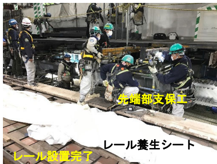
写真-5 先端部支保工組立状況(後半)
