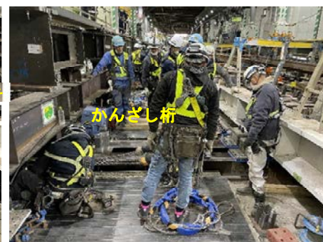
写真-3 人力移動状況(6t レバブロック)
