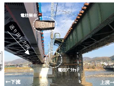
写真-2 新設橋りょうと既設橋りょう
