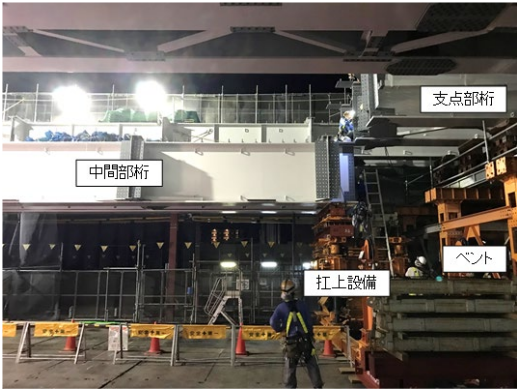
写真-3 扛上架設状況
