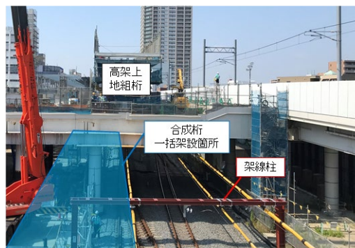
写真-1 架設箇所と架線柱
