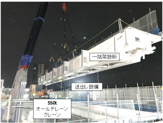
写真-2 一括架設状況
