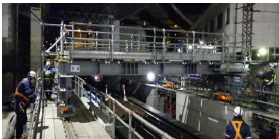
写真-3 搬送台車実証試験（軌条走行試験）
