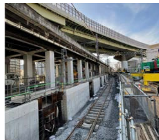
写真-5 工事桁撤去直後状況
