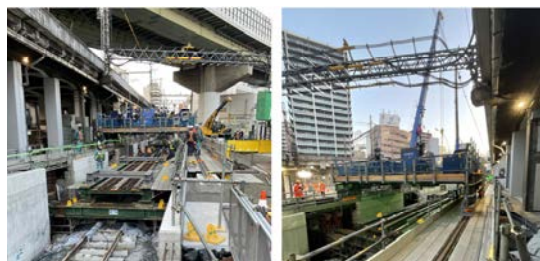
写真-4 搬送台車による縦取り状況
