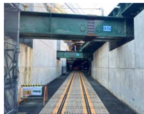
写真-1 軌道内舗装
