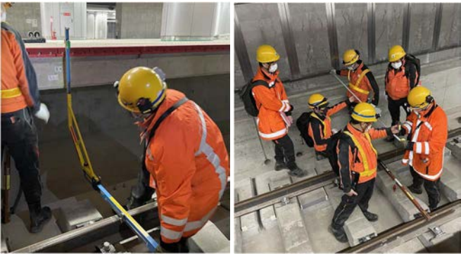
写真－1 出来形測定の状況（手計測）
