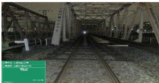
【写真 1】LR 化施工前(定尺)
