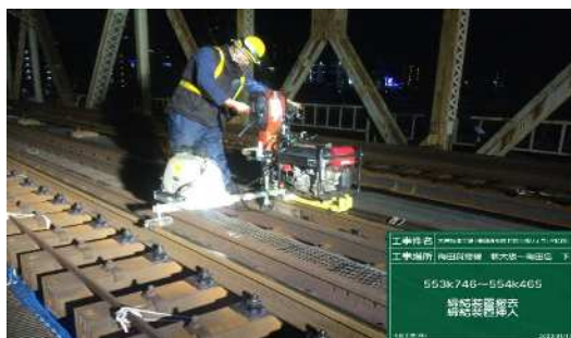
【写真 4】橋上 TP 交換
