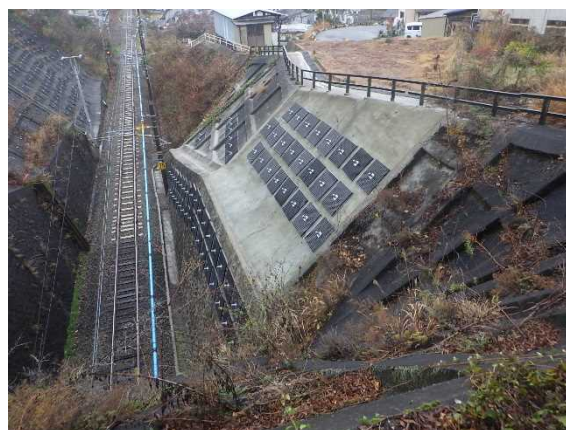
写真-2 全景写真（施工後）
