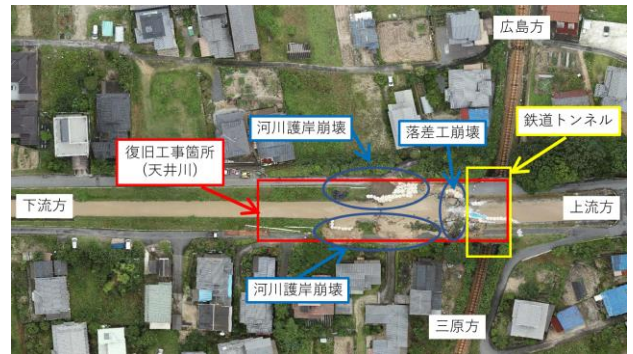
写真-1 当該箇所（被災直後）
