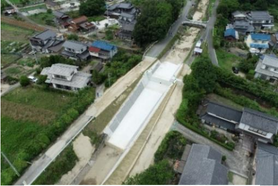
写真-5 当該箇所 (復旧工事後)
