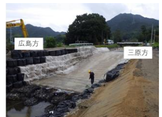
写真-3 応急対策状況
