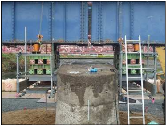
写真-3 橋桁仮受け状況
