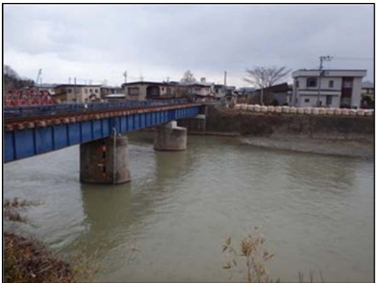
写真-5 復旧完了状況
