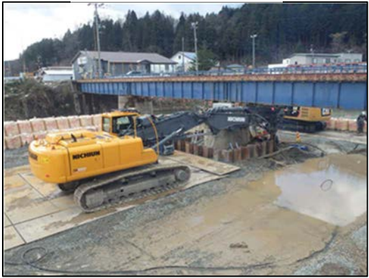
写真-4 桁下パイラー鋼矢板打設状況
