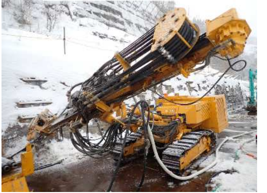
図-6 棒状補強材打設状況
