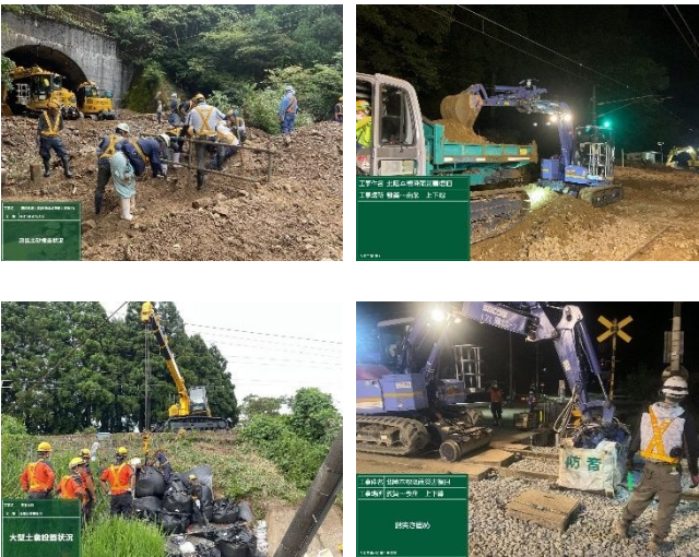
写真-2 応急復旧状況
