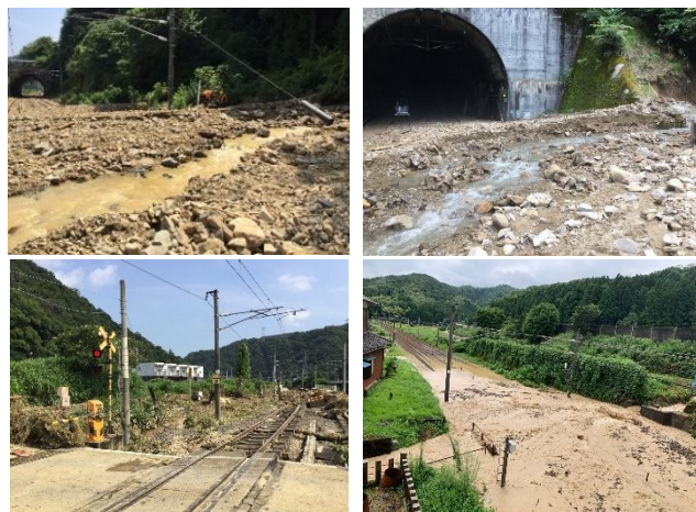
写真-1 被災状況
