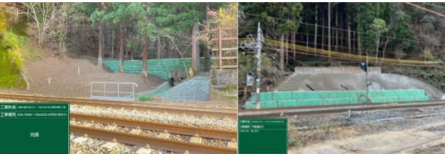
土砂流入防止堰 斜面復旧工 写真-3 本復旧工事
